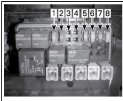
FUSIBILI - SCATOLA FUSIBILI SINISTRA
