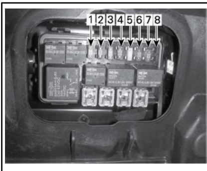
FUSIBILI - SCATOLA FUSIBILI DESTRA
