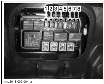
FUSIBLES - BOÎTE À FUSIBLES DROITE
