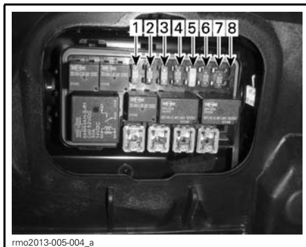
FUSIBLES - BOÎTE À FUSIBLES DROITE
