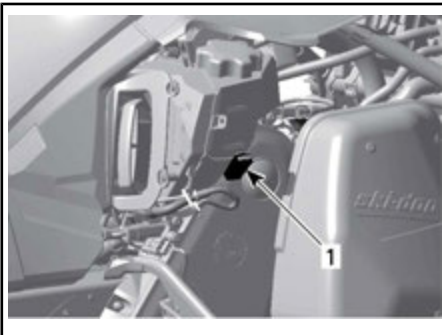
TYPBILD — HÖGER SIDA AV MOTORRUMMET
