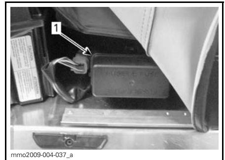
1. Boîte à fusibles
