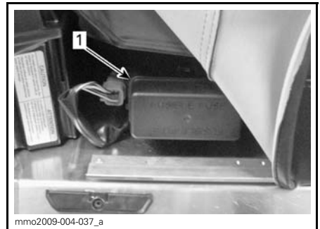
1. Boîte à fusibles
