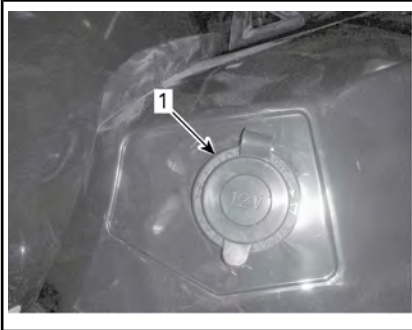
1. Электрическая розетка (12 В)
