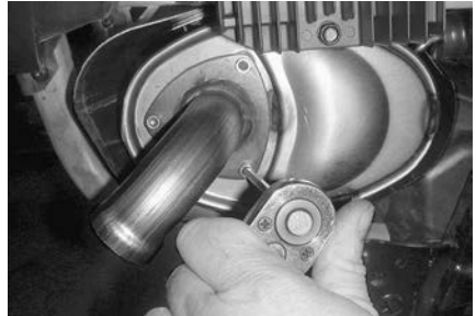
TYPEBILDE – FJERNING AV UTBLÅSINGSRØR
